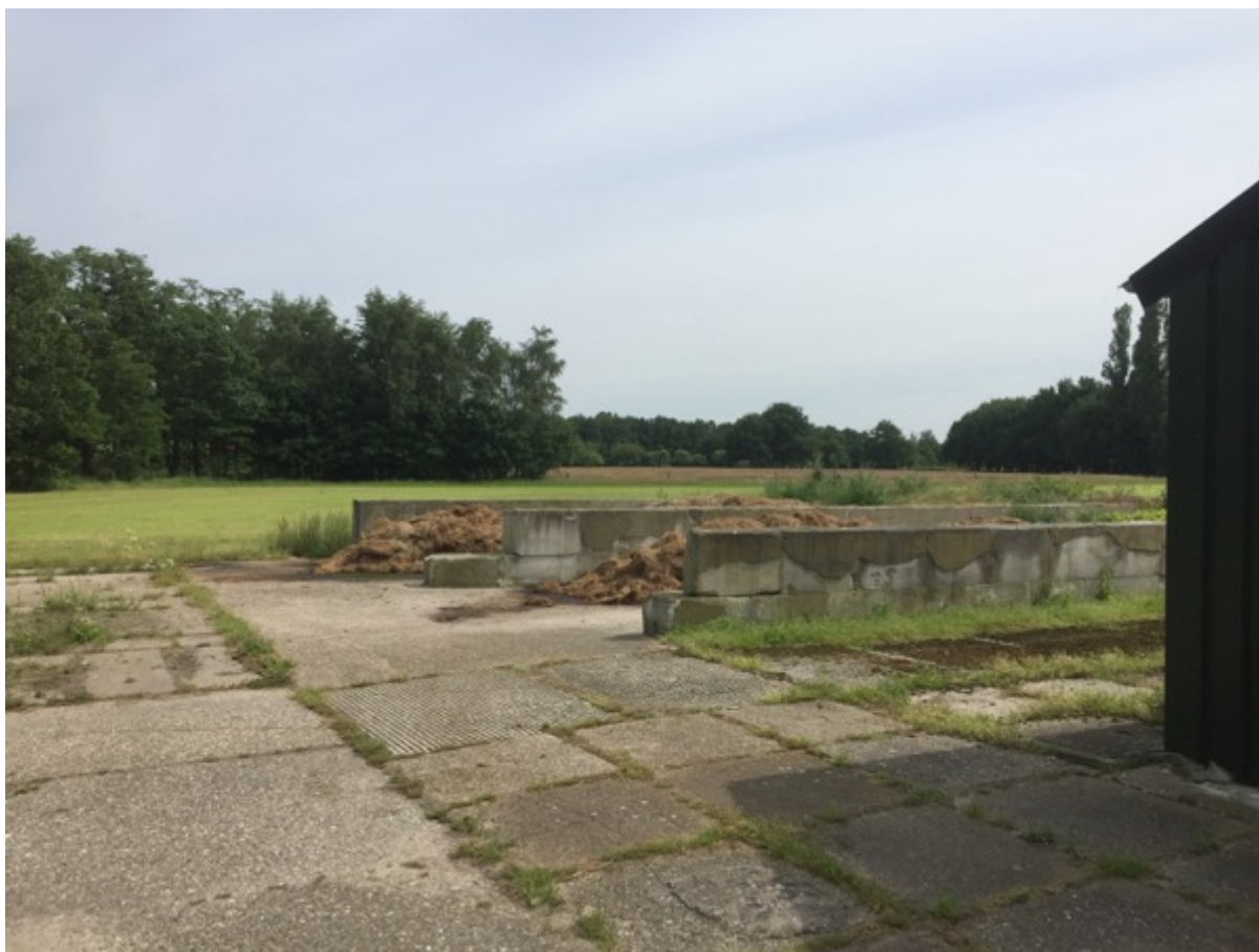
Figuur 11: Foto met daarop de bestaande en te slopen meststleuf.
