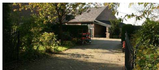
Zicht op de garage
