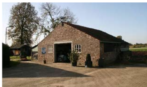
Zicht op de varkensstal met de muren van metselwerk en zadeldak met rode dakpannen
