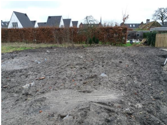
Foto 5 – perceelnr. 4947 en 4948 (bouwkavel 2 en 3)
