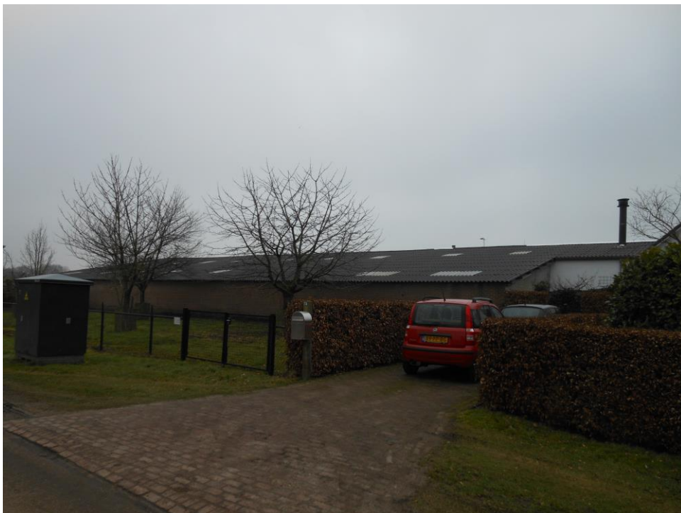
Voormalige bedrijfsbebouwing (straataanzicht).
