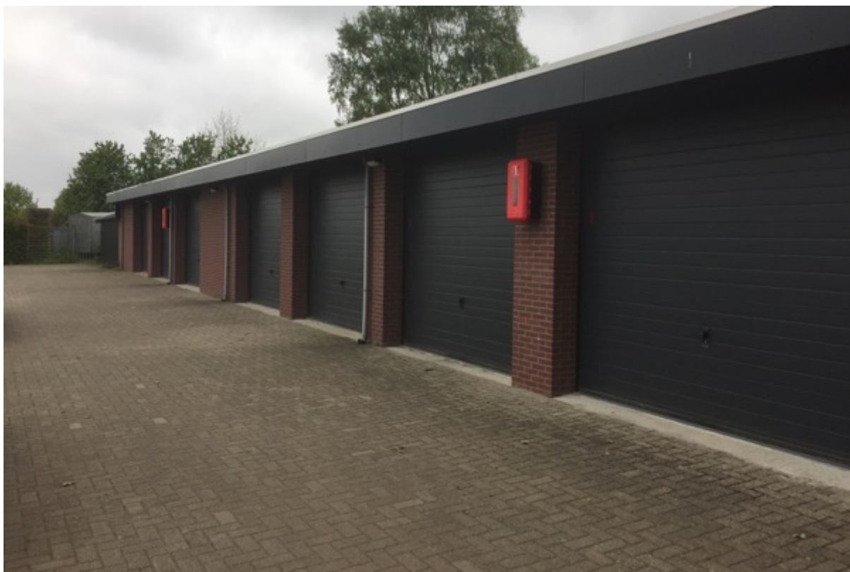
Foto van de bestaande loods en de terreininrichting
