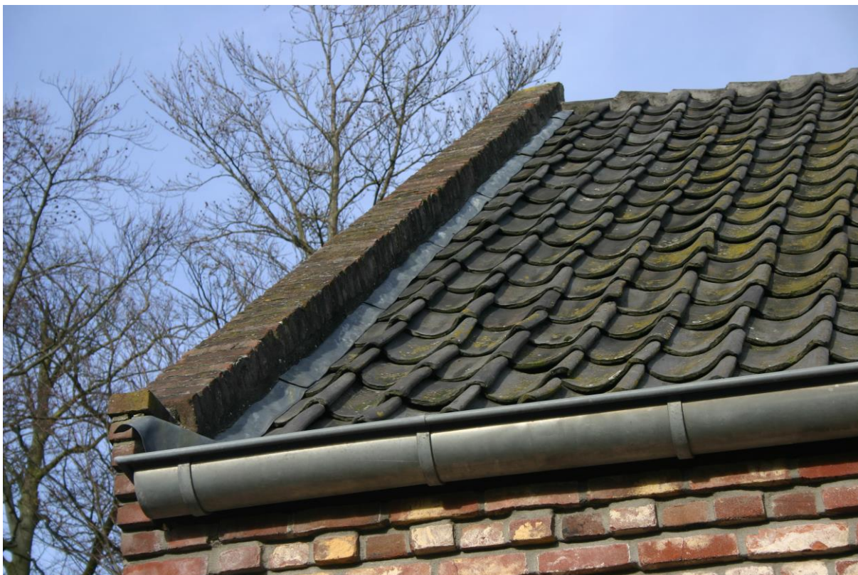
Figuur 8. Het dak van de schuur is ongeschikt voor vleermuizen of vogels.
