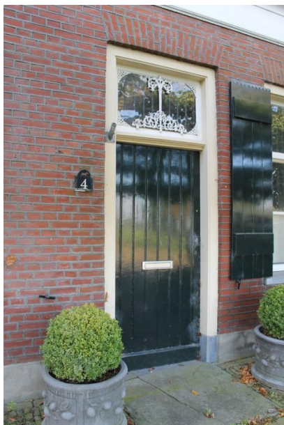
De vermoedelijk oorspronkelijke voordeur
