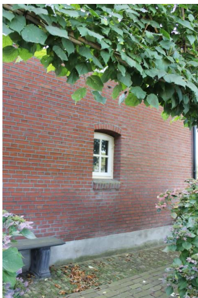
Het vernieuwde stalvenster
