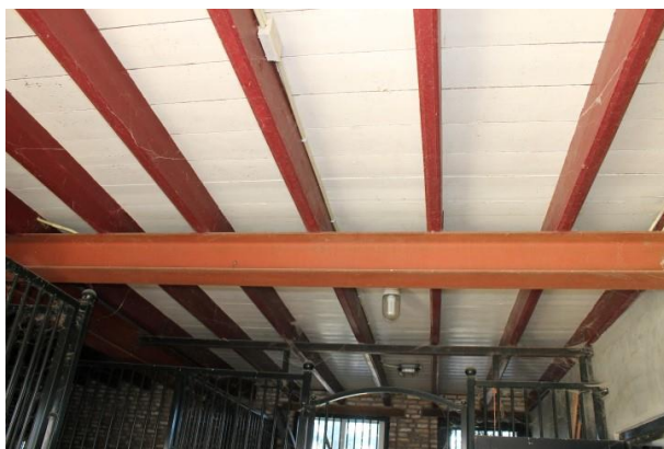
oorspronkelijke balklaag met stalen balk uit 2000
