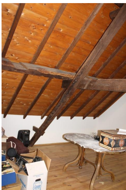
Constructie met bouwsporen
