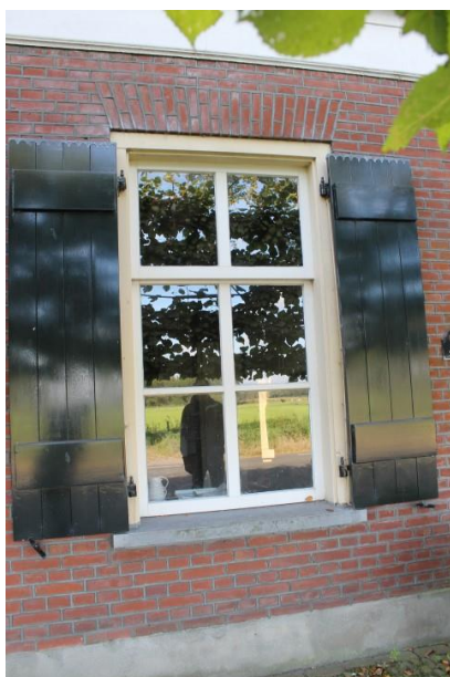
Het vermoedelijk oorspronkelijke kozijn met vernieuwde ramen en luiken
