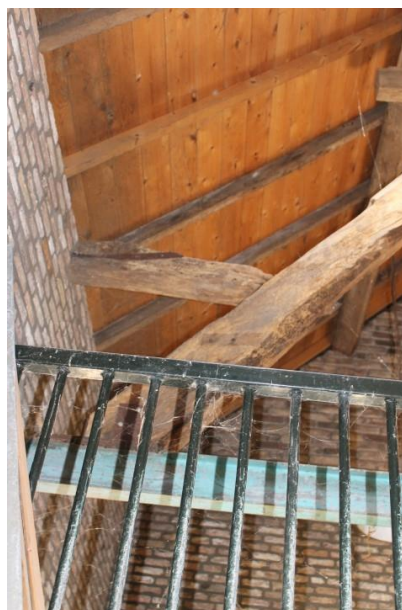
Spant van hergebruikt hout
