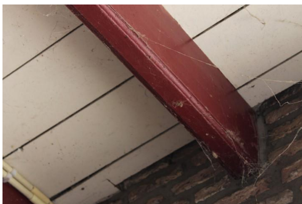
Oorspronkelijk balk met duivenjagerafwerking
