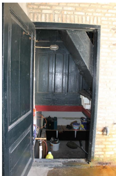
De keldertoegang waarin de bedstee betimmering en trap naar zolder zichtbaar zijn
