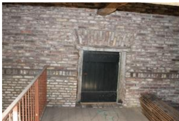
Kozijn hooiluik in nieuwe binnenmuur
