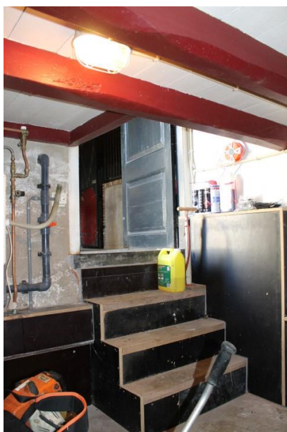
Oorspronkelijk 20 ste -eeuwse kelder met oorspronkelijke balklaag en vloerdelen
