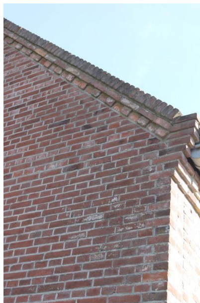
De sierrand bovenaan de topgevel
