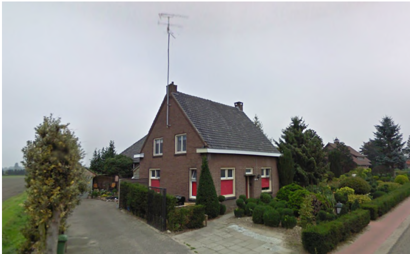
Bestaande bedrijfswoning Oisterwijkseweg 12a (maps.google.nl, september 2010)
