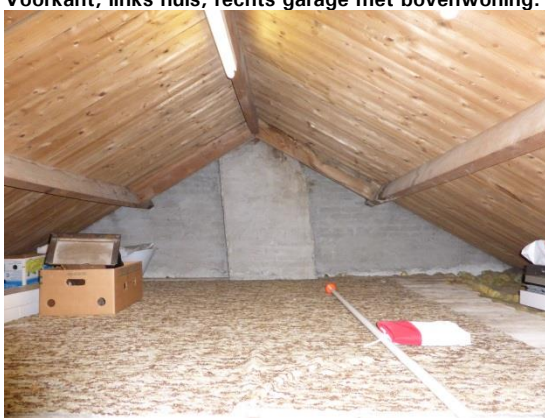
Zolder woonhuis, met betimmering.
