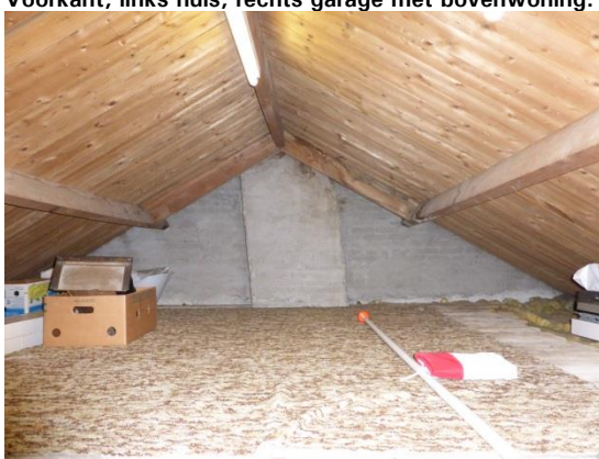
Zolder woonhuis, met betimmering.
