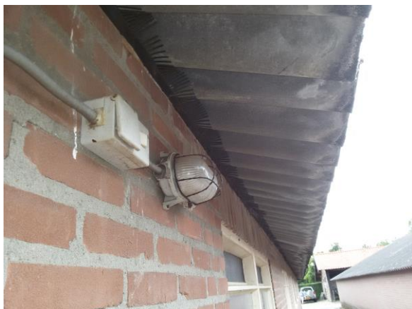
Foto 3. Vogelvides onder de dakrand
