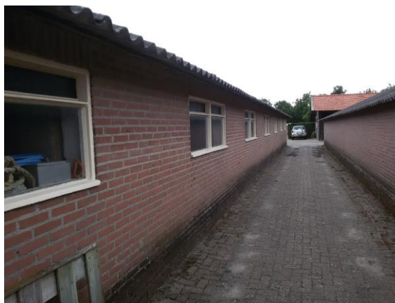
Foto 2. Tussenruimte tussen de om te bouwen stallen
