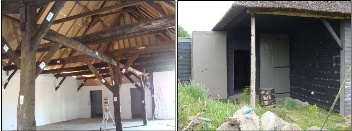
Figuur 27: Bestaande schuur binnenzijde (links) en Overkraagde inham ter plaatse van de hoge deeldeuren (rechts)
