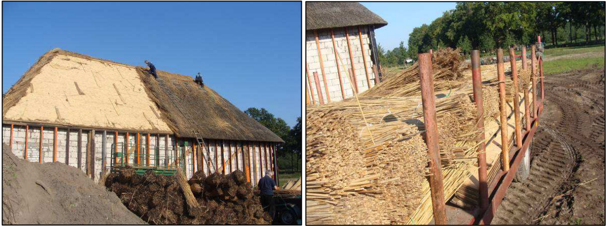
Figuur 30: Demontage schuur en verwijderen riet (links) en Verwijderde riet opgebost voor hergebruik (rechts)
