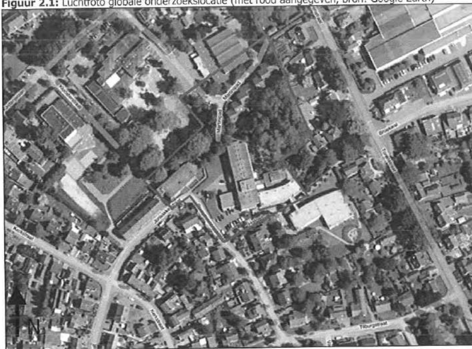
Figuur 2.1: Luchtfoto globale onderzoekslocatie (met rood aangegeven, bron: Google Earth)
