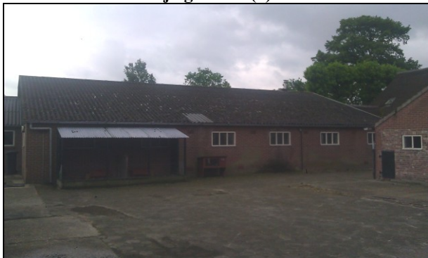
Te slopen bedrijfsgebouw (4)
