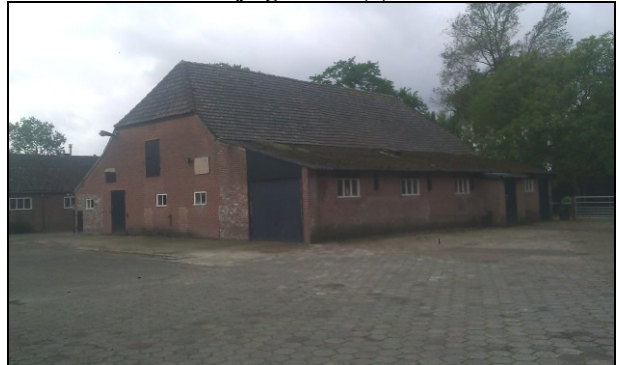
Te slopen bedrijfsgebouw (1)
