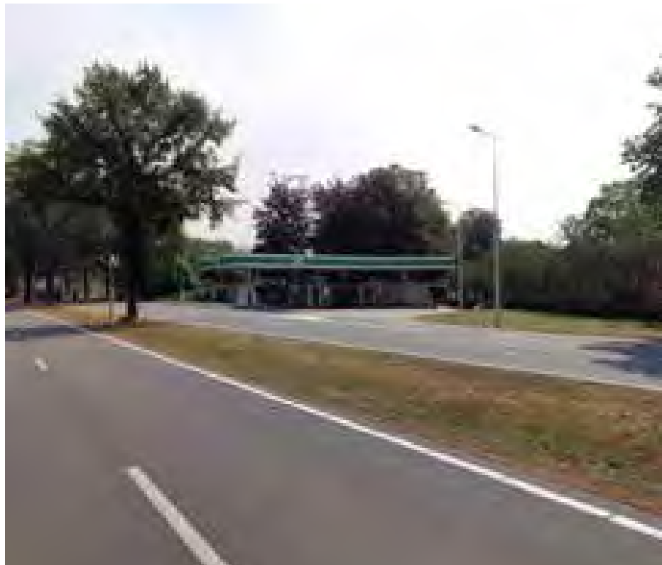
Bestaande locatie tankstation
