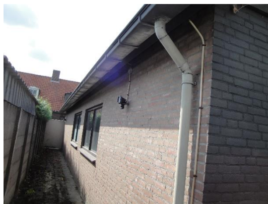
Het bedrijfspand (rechts)
