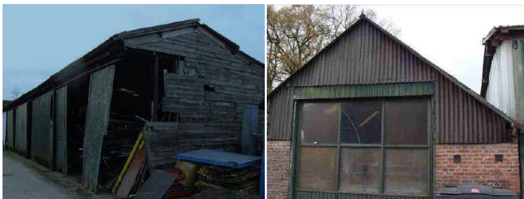
Figuur 13 Te slopen loods en schuur (bron: Staro natuur en buitengebied)
