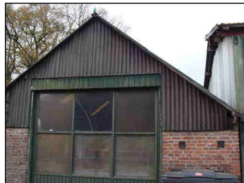
Foto 2. Te slopen schuur
