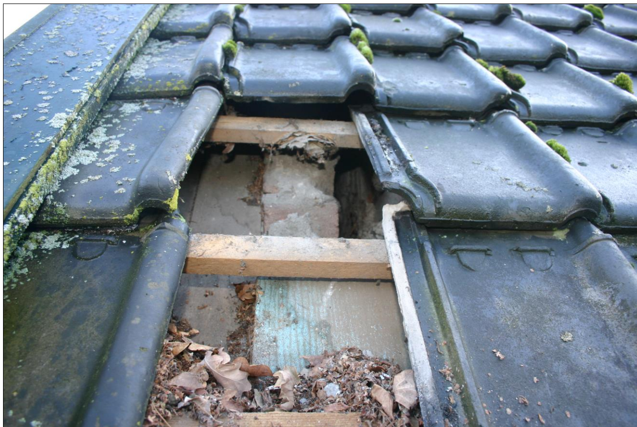
Figuur 4.2.1. Een kijkje onder het dak van gebouw F: geen vleermuisuitwerpselen aanwezig.
