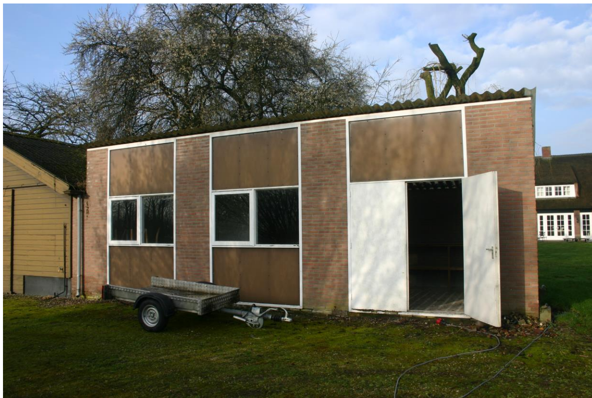
Figuur 3.1.3. Gebouw D is een opslagruimte met halfsteense muren en een enkelwandig dak.
