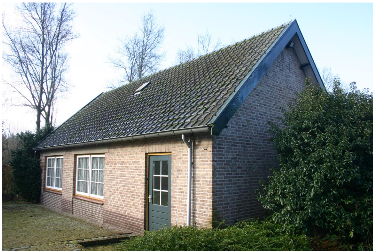
Figuur 3.1.4. Gebouw F heeft spouwen en een dak met dakpannen.
