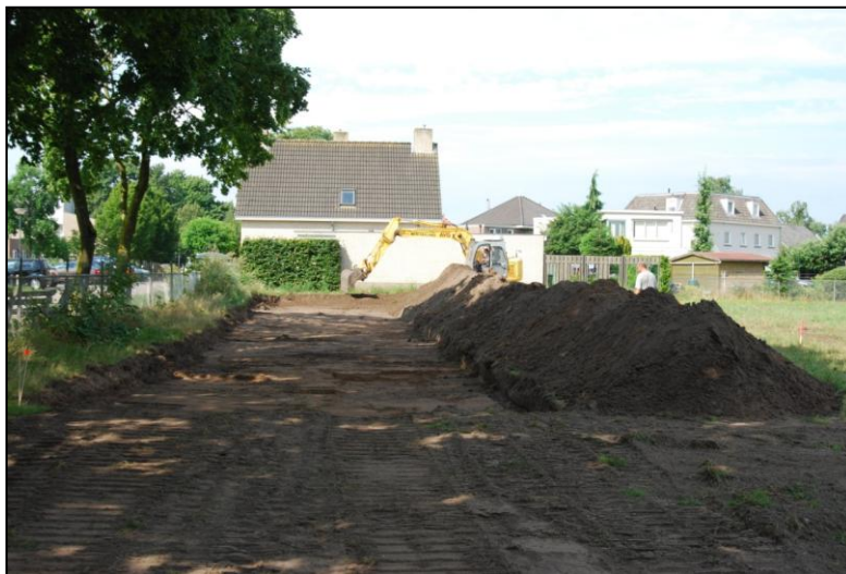
Afb. 2 – Laagsgewijs ontgraven ferro vervuilde locatie m.b.v beveiligde kraan.
