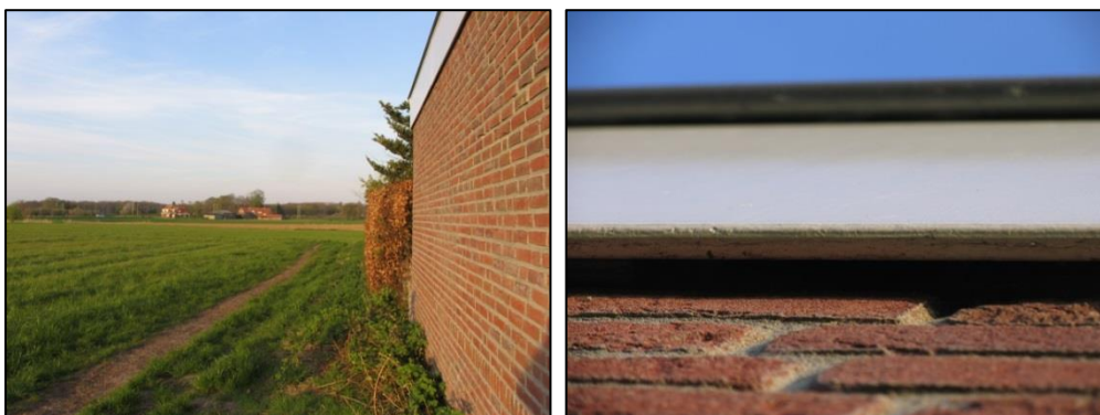
Gebouw met houten afwerkplaat aan de zijde van Het Nieuwland.
