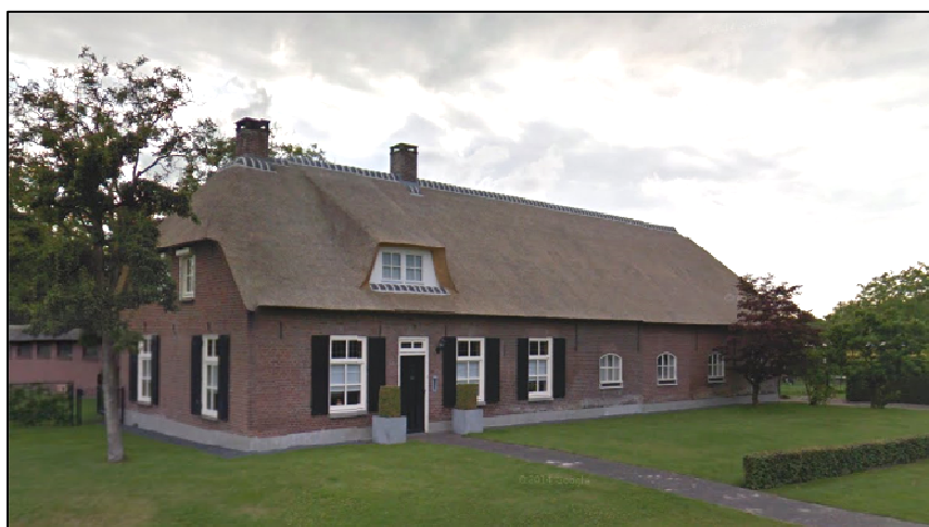
Figuur 8: Huidige verschijningsvorm woning Gommelsestraat 3
