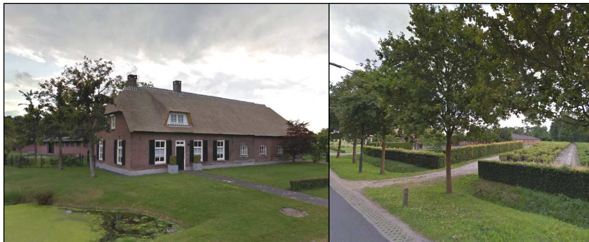
Figuur 5: Impressie bedrijfsgebouwen Gommelsestraat 3
