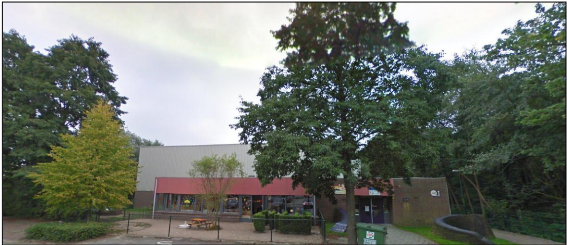
Aanzicht van Sporthal Beekdal vanaf het voor het gebouw gelegen parkeerterrein
