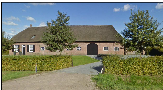
Figuur 10: Langgevelboerderijen in Eind: gemeentelijk monument Belversedijk 1
