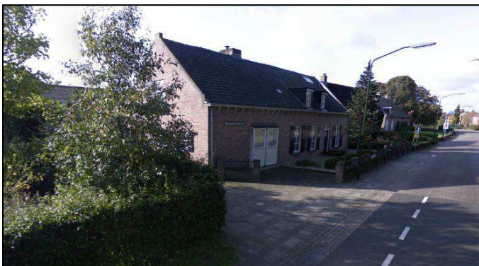
Figuur 9: Langgevelboerderij in Eind: Belversedijk 2
