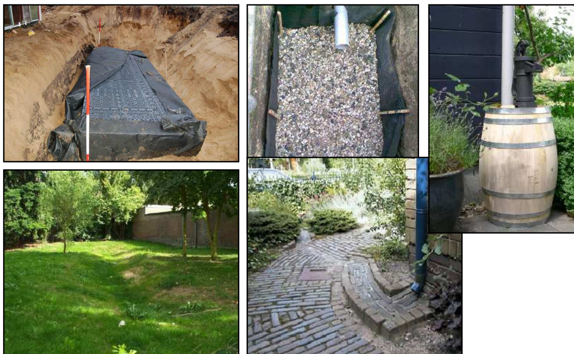
Figuur 37: Voorbeelden van infiltratiemogelijkheden.
