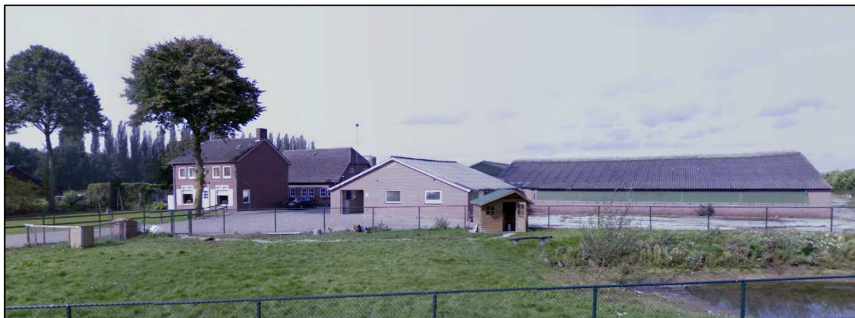
Figuur 11: Foto's van de bebouwing binnen het plangebied (Bron: Google Streetview)
