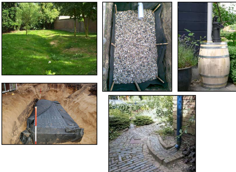
Figuur 19: Voorbeelden infiltratiemogelijkheden
