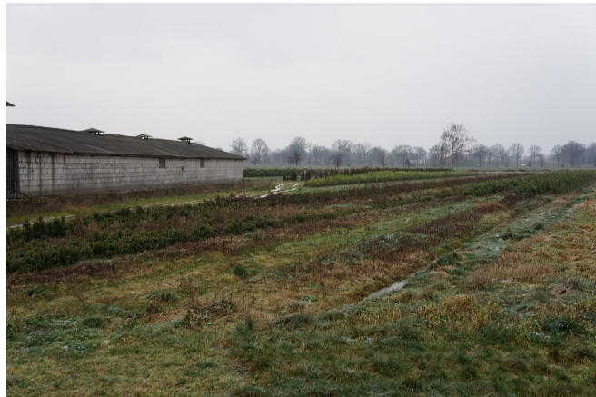
Zicht vanaf Hooghoutseweg op deels te verwijderen bebouwing.
