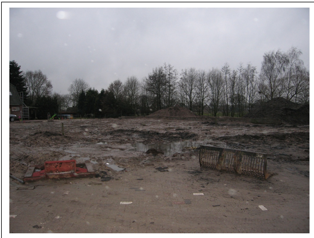
Foto 2. Het braakliggend bouwterrein op de onderzoekslocatie
