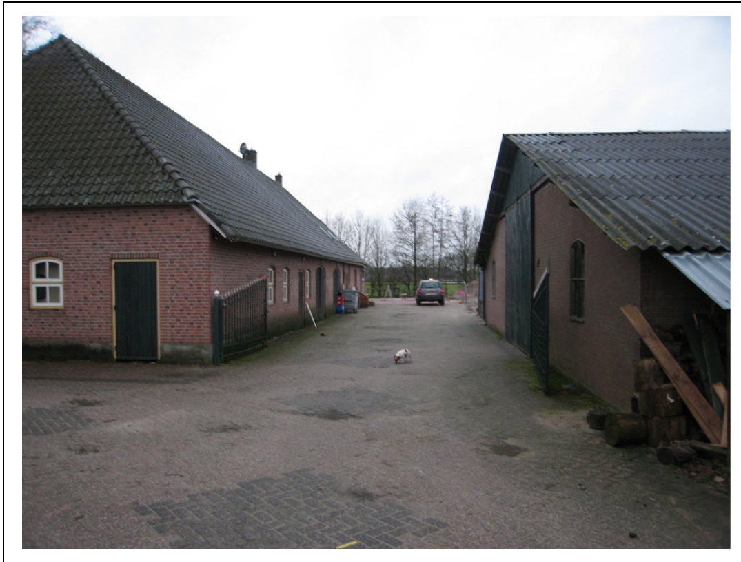
Foto 1. De te slopen schuur (rechts) en het woonhuis (links)
