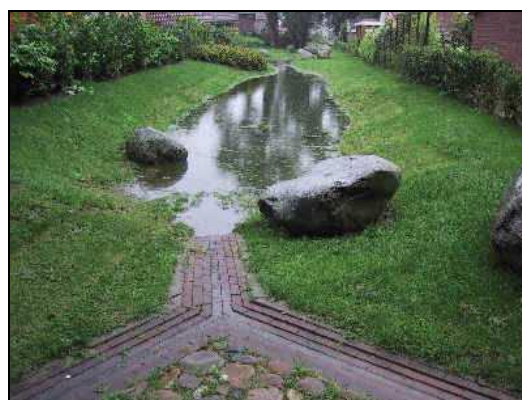
Afbeeldingen 6 en 7: Schematische weergave en voorbeeld van een infiltratieveld, bassin of greppel.
