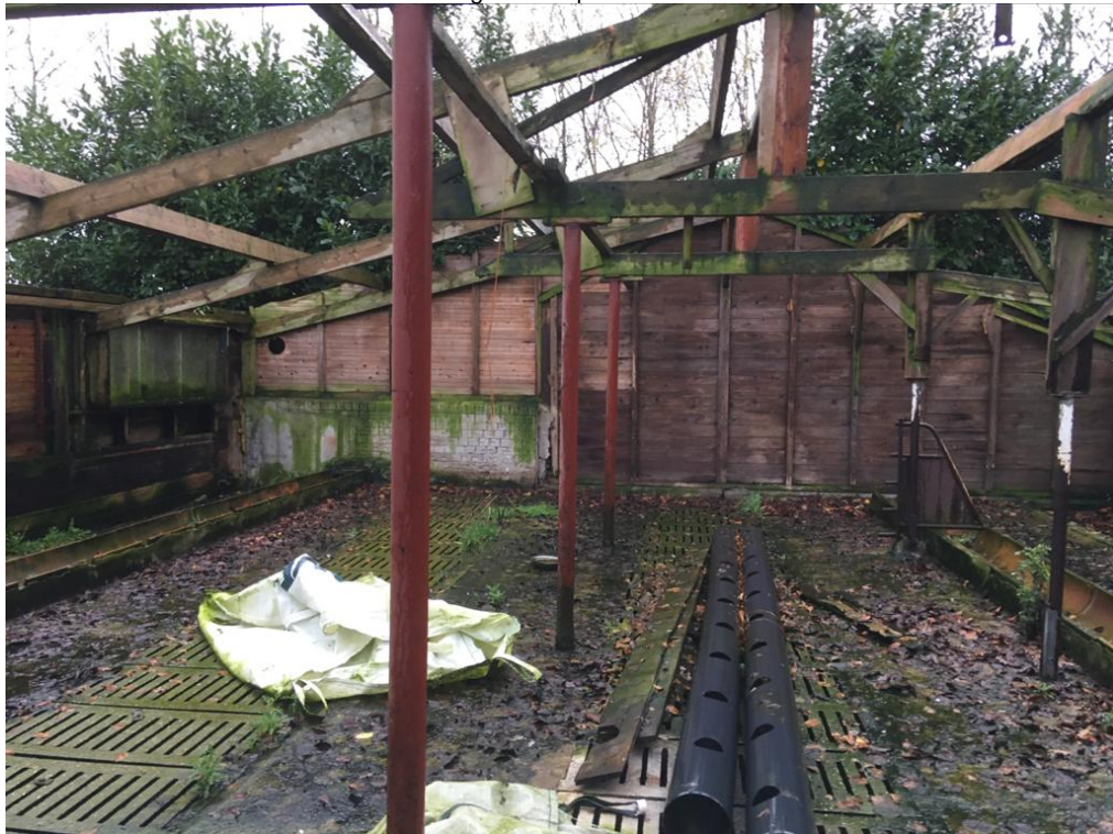
• Afbeelding 14: te slopen varkensstal
