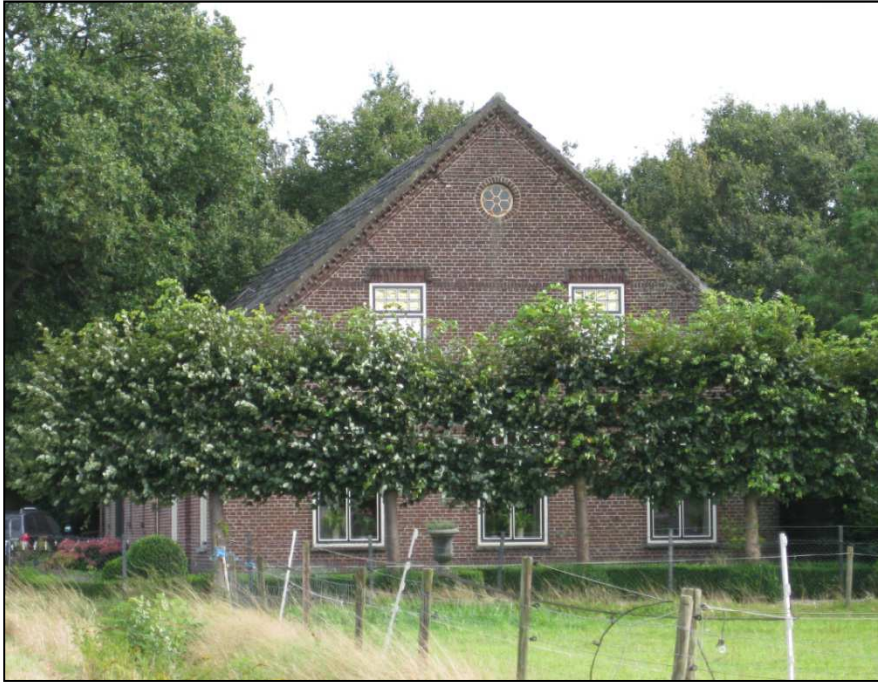
Figuur 31: Zijgevel woongedeelte boerderij Kapellaan 8
