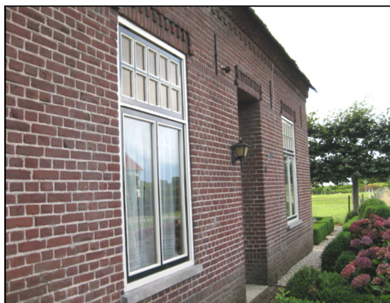
Figuur 30: Voorgevel woongedeelte boerderij aan Kapellaan 8
