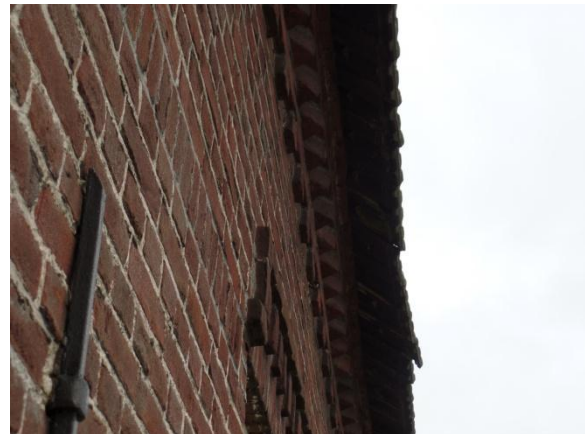
Fig.11 Aansluiting dakpannen op voorgevel
