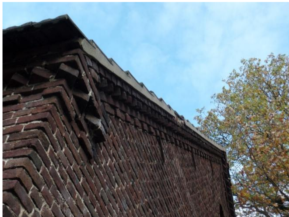
Fig.10 Aansluitng dakpannen op oostelijke kopgevel
