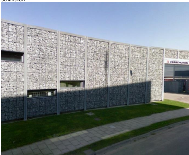
Openingen in gevel in combinatie met schanskorf
