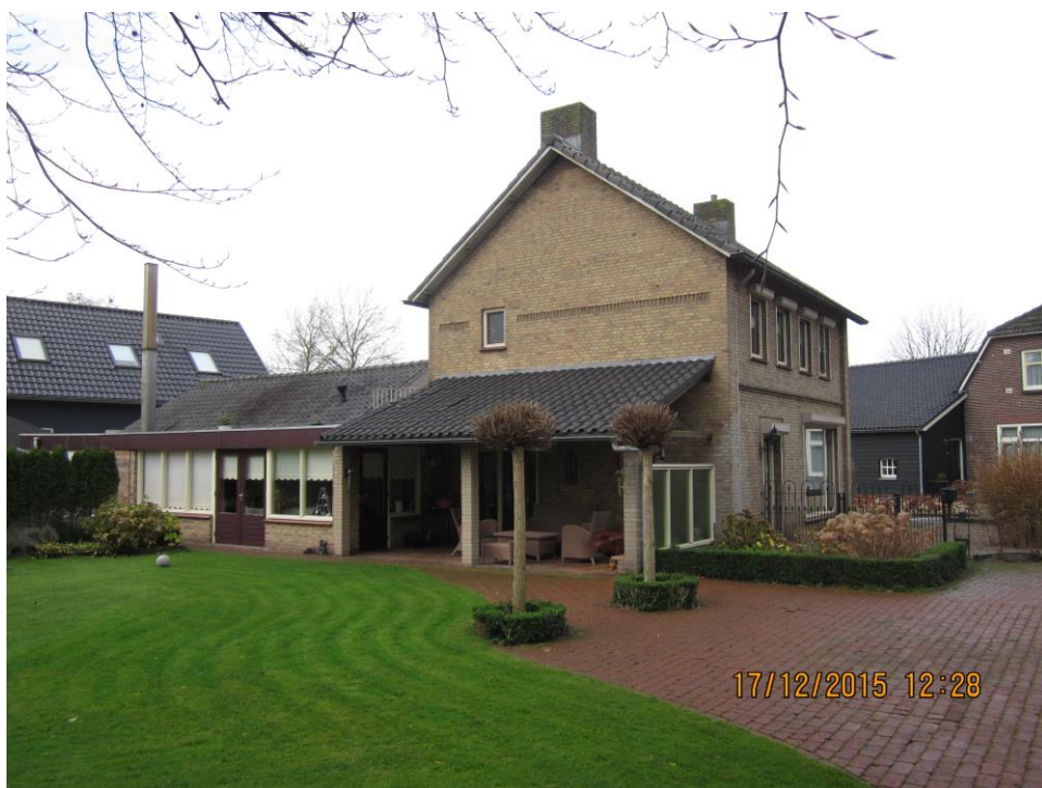
Foto-3 Bestaande woonhuis en bijgebouwen aan de Torenstraat 7 te Gassel
