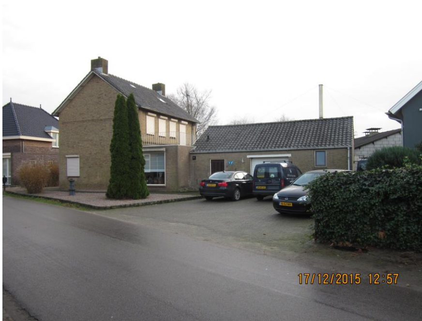
Foto-1 Bestaande woonhuis en bijgebouwen aan de Torenstraat 7 te Gassel
