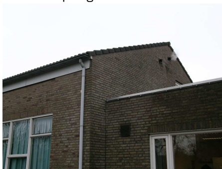
Gebouwen met overhangende dakpannen in het plangebied.
