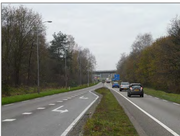
Foto 5: Zicht op viaduct over de A50
