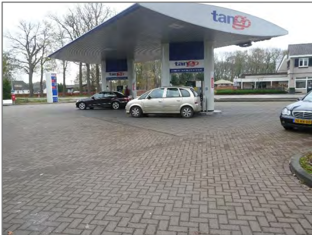
Foto 98: Afleverinstallatie met pompeilanden \Tango Tankstation
