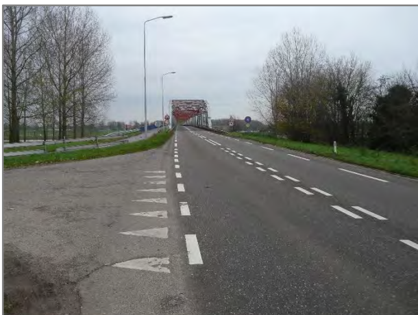
Foto 226: Maasbrug vanuit N324 gezien
