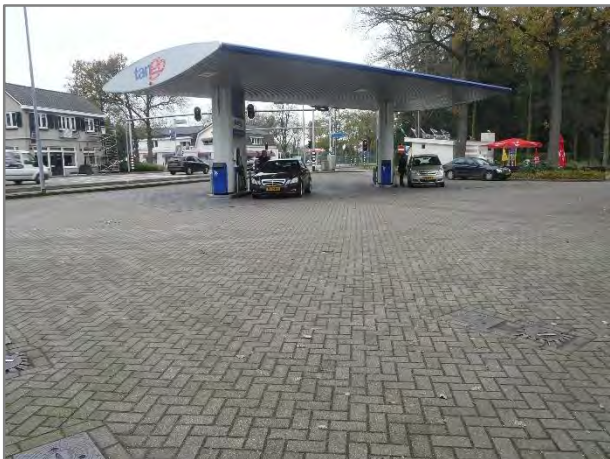
Foto 100: Afleverinstallatie met pompeilanden
