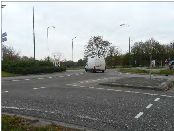
Foto 83: Rotonde N324 – Corridorweg – Mgr. Borretstraat
