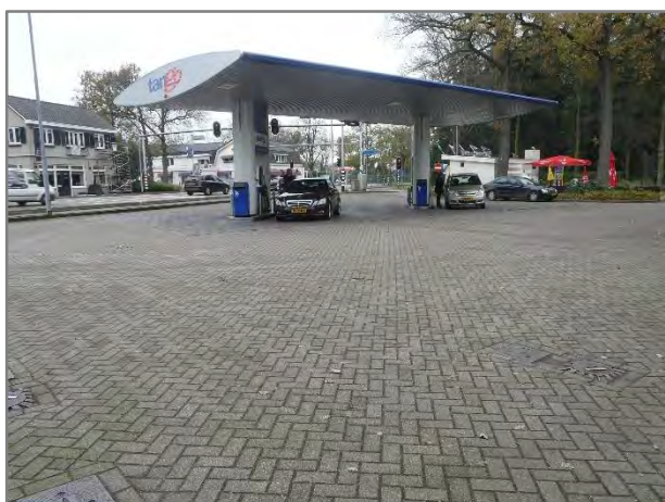
Foto 100: Afleverinstallatie met pompeilanden
