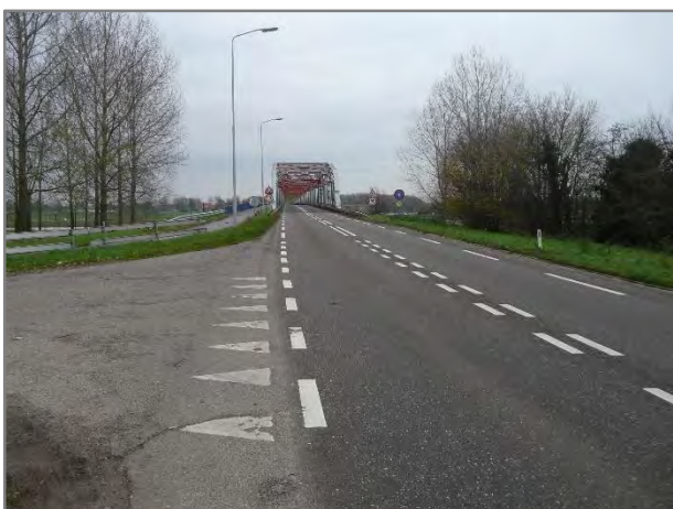
Foto 226: Maasbrug vanuit N324 gezien
