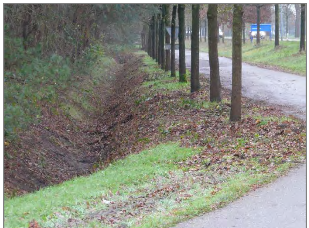
Foto 14: Sloot/watergang zuidelijk van parallelweg
