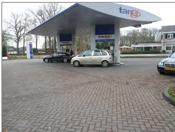
Foto 98: Afleverinstallatie met pompeilanden \Tango Tankstation
