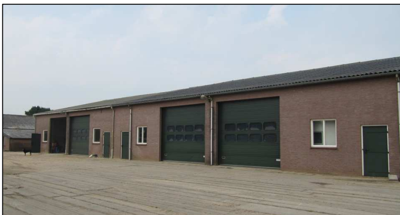
Figuur 8. Te behouden en te vergroten/uit te breiden loods op de locatie Maasveld 14 Gassel.
