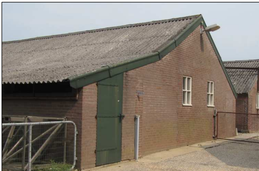
Figuur 16. Hemelwaterafvoer bij de te slopen opstallen.
