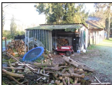
Figuur 7. Bijgebouw met houtopslag aan zuidzijde.
