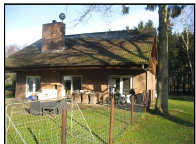
Figuur 5. Aanwezige woonhuis.
