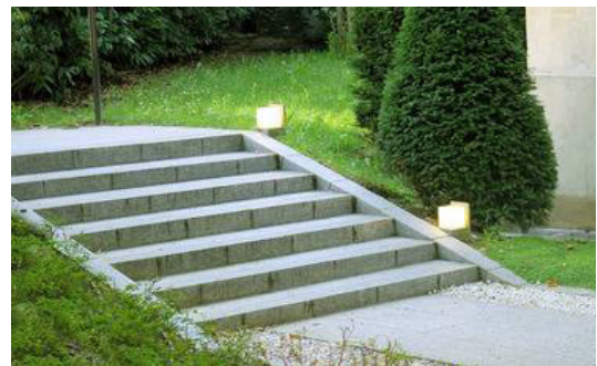
Betonnen trap met taludband
