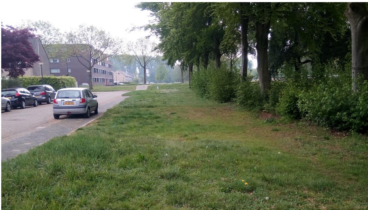
Figuur 12: Laagte nabij boring 5. De trottoirband volgt de verlaging.
