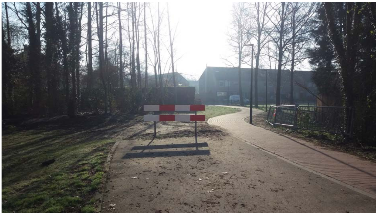
Foto 15: aansluiting bestaand fietspad
