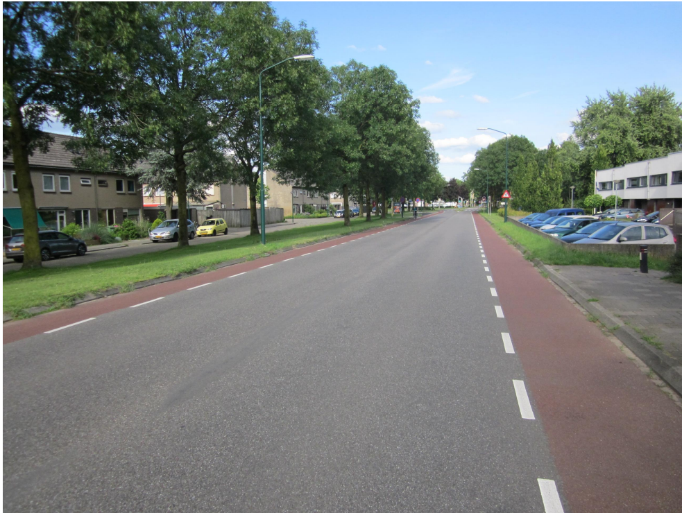
Afbeelding 8: Stoofweg oostelijk van de Stoofbrug
