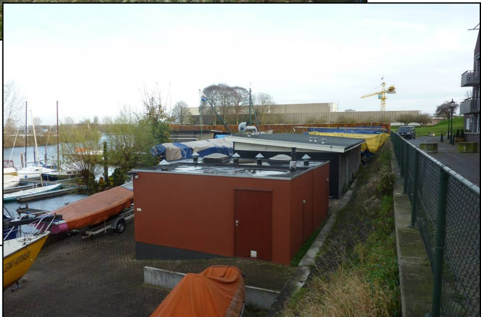
Foto bestaande clubgebouw en sanitaire ruimte
