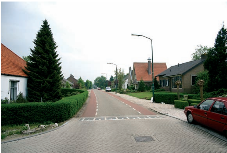
Afb. 20. De Bronckhorstweg met aan weerszijden bebouwing met de karakteristieke lintstructuur gezien in oostelijke richting.
