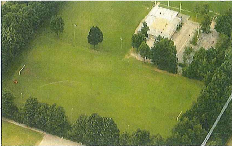
Afbeelding: bestaande situatie velden met bestaande lichtmasten.
