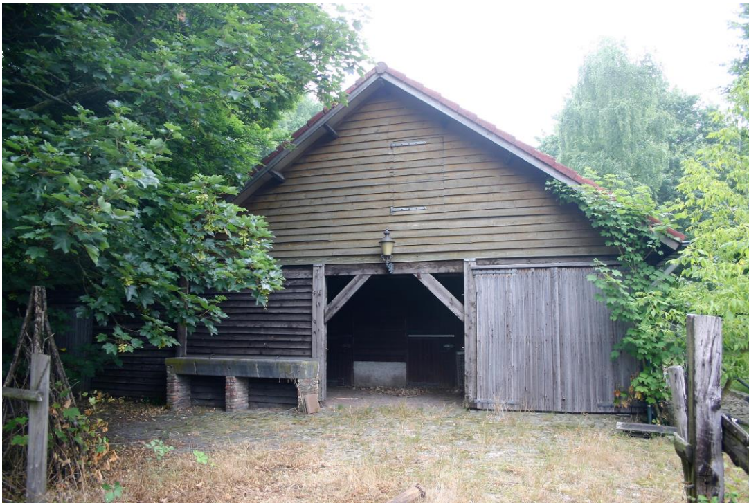
Figuur 4.5.1. In de voormalige hertenstal zijn geen vogelnesten aanwezig.
