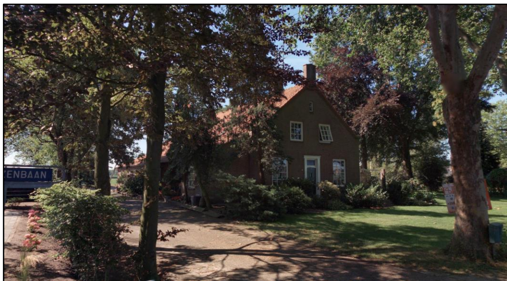
Foto boerderij gezien vanaf de oostzijde. Bron: streetsmart.cyclomedia.com, 2019
