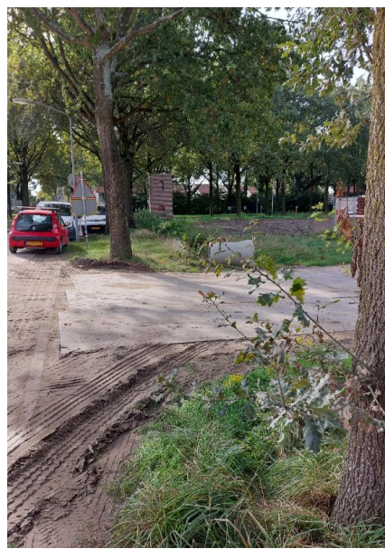
Figuur 5.8 Stamvoet niet goed beschermd, waardoor vrachtauto's af en aan rijden over de stamvoet wat bodemverdichting veroorzaakt, rijplaten onvoldoende.
