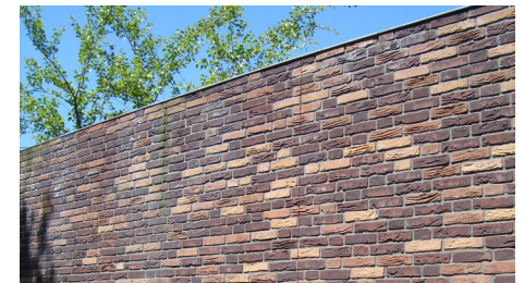
verrijking van de muur met metselwerkverbanden
